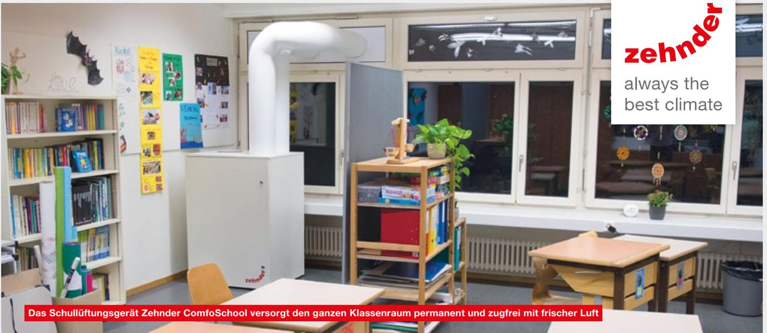
Das Schullüftungsgerät Zehnder ComfoSchool versorgt den ganzen Klassenraum permanent und zugfrei mit frischer Luft
