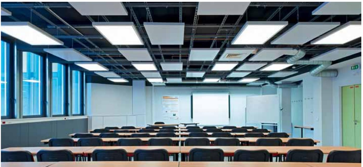
Il complesso di edifici si estende su una superficie complessiva di 70.000 m<sup>2</sup>. Del sistema di pannelli radianti a soffitto Zehnder Carboline adottato sono stati installati 12.000 moduli su 7.275 m<sup>2</sup>.
