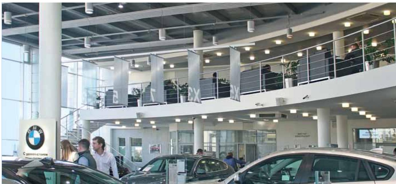
Al fine di consentire le migliori condizioni climatiche all'interno dello showroom e dell'officina, si è optato per un sistema di pannelli radianti a soffitto Zehnder ZBN. Sono stati installati complessivamente 150 m<sup>2</sup> di moduli singoli.
