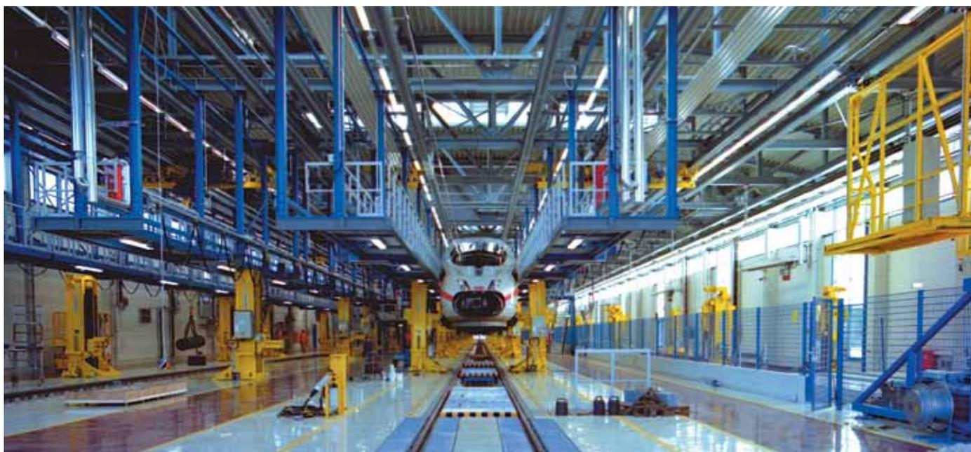
Sono stati installati 39 moduli di pannelli radianti con una lunghezza di 1.147 m. Il posizionamento ha richiesto una certa destrezza, per non intralciare i carroporti che si estendono per l'intera lunghezza del capannone a tre binari.
