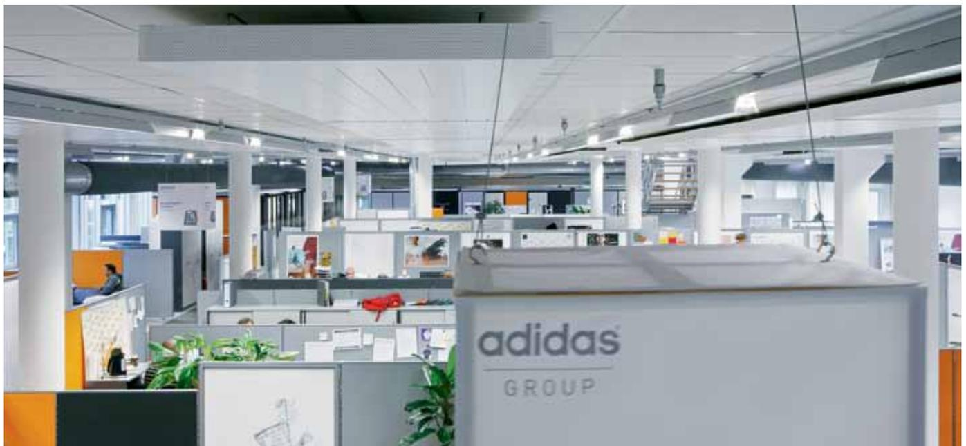
Là dove si accumula maggiormente l'aria calda occorre raffreddare di conseguenza e viceversa. Grazie all'elevata percentuale di irraggiamento dei pannelli piatti si ottiene un clima ambientale confortevole con un'efficienza elevata.
