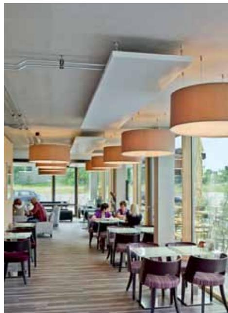
Tutti gli uffici e la caffetteria sono climatizzati con Zehnder Carboline. I pannelli leggeri da costruzione in grafite naturale garantiscono una distribuzione della temperatura particolarmente veloce, uniforme ed efficiente.
