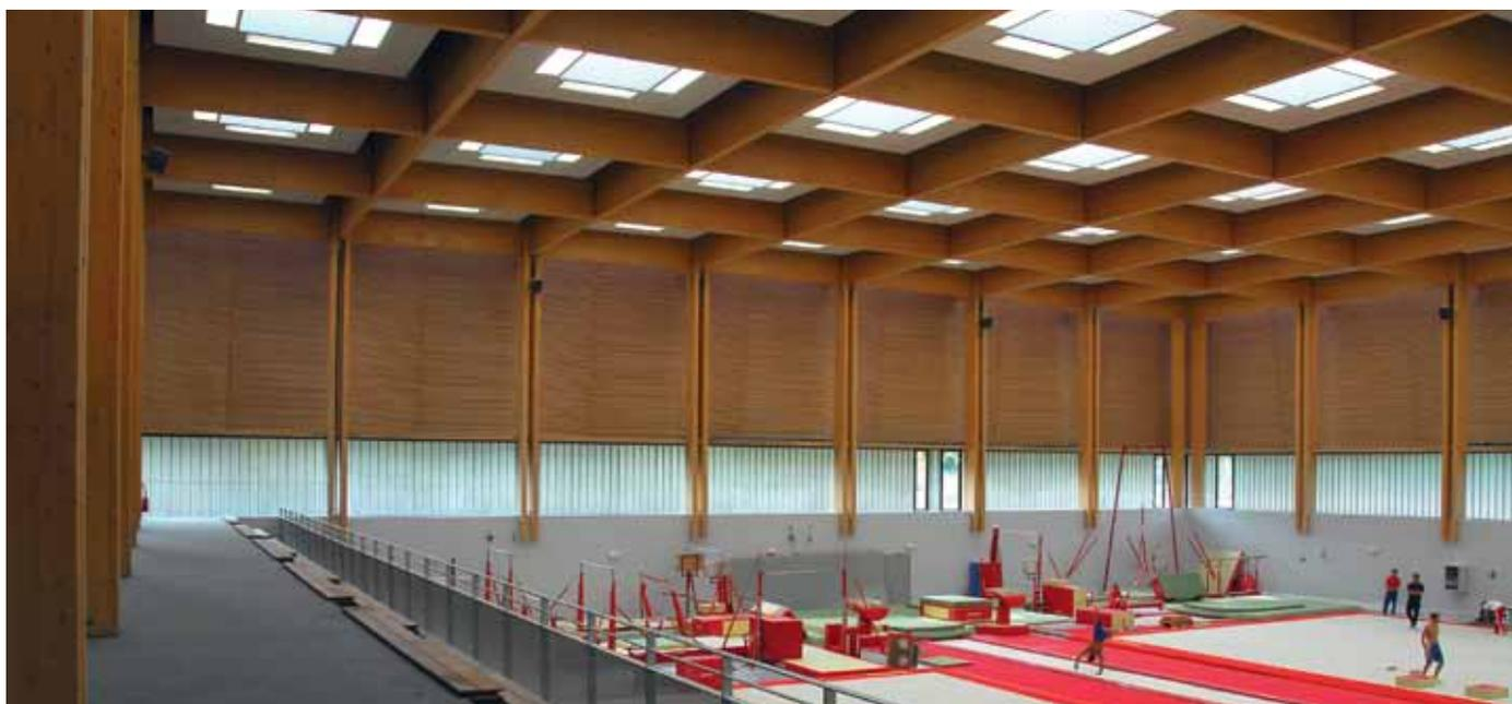
I 12.000 m<sup>2</sup> dell'edificio sono stati dotati di pannelli radianti a soffitto Zehnder Reverse. Complessivamente i 1.836 m<sup>2</sup> si inseriscono perfettamente nell'architettura originale.
