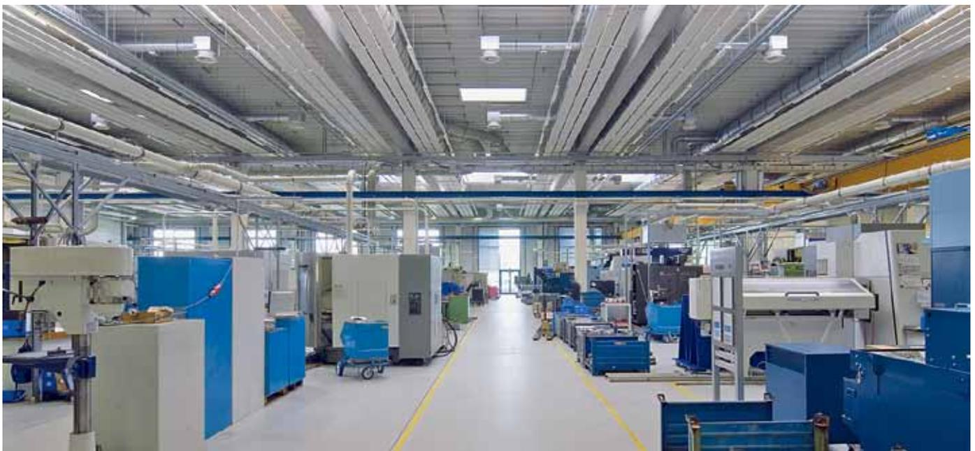
Sono stati utilizzati i prodotti Zehnder ZIP o Zehnder Como a seconda dei reparti e delle esigenze specifiche. Nei controsoffitti a vela chiusi Zehnder Como sono stati integrati gli elementi per l'illuminazione e le bocchette per la ventilazione.
