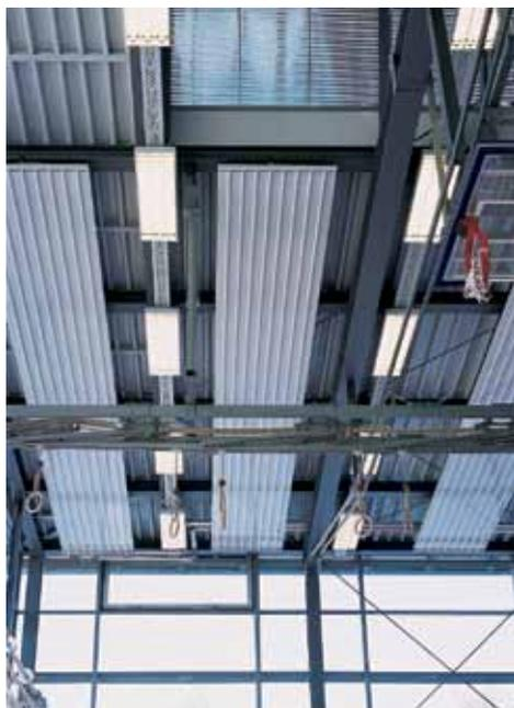
Così i 12 pannelli radianti a soffitto Zehnder sono stati integrati a raso con il soffitto per tutta la lunghezza del padiglione, adattati al centimetro e dotati di testate rialzate che brillano per gli ottimi risultati in materia di efficienza.
