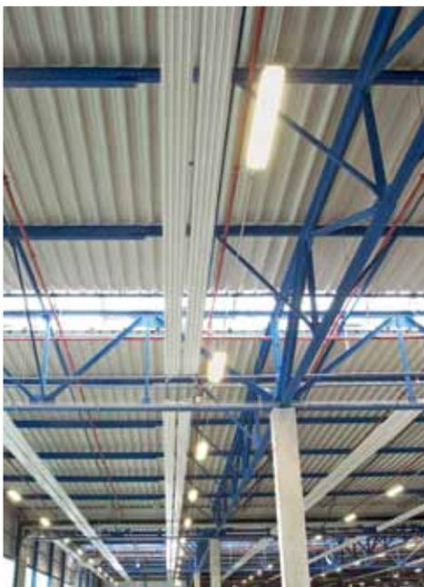
Anche per quanto riguarda la tecnica di climatizzazione si è puntato su potenza ed efficienza, ovvero su un sistema di pannelli radianti a soffitto Zehnder. Sono stati installati 6.400 m<sup>2</sup> pannelli radianti di tipo Zehnder ZIP e Zehnder ZBN.
