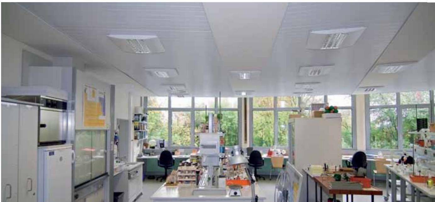
E il risultato ha fatto scuola: il sistema è stato installato anche nella sezione di chimica, in abbinamento ad un impianto di ventilazione. Le bocchette dell'aria di mandata e di ripresa sono state integrate a raso con i controsoffitti a vela, l'illuminazione è stata collocata sulle vele.
