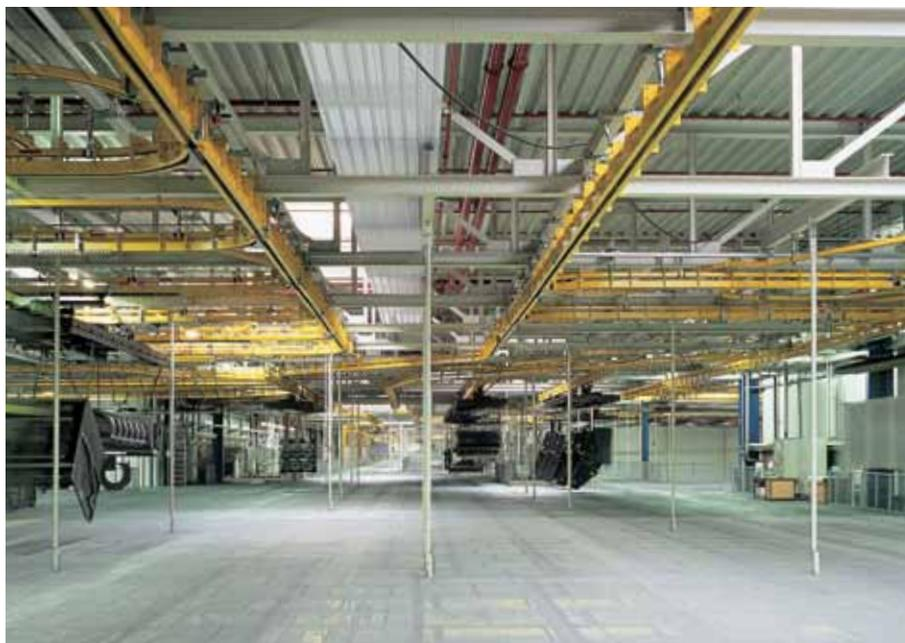
Nei nuovi capannoni di montaggio sono stati montati complessivamente 419 elementi radianti a soffitto Zehnder. La sospensione di tali elementi è stata integrata agevolmente nelle complesse linee di lavorazione dell'impianto di verniciatura completamente automatizzato.
