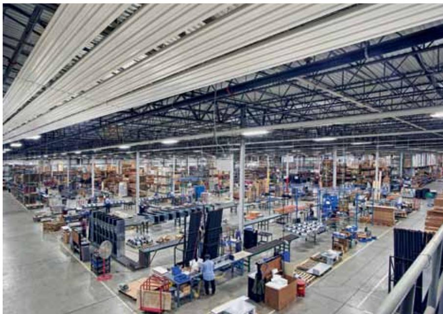
Sono stati impiegati pannelli radianti di tipo Zehnder ZIP. Su 13.000m<sup>2</sup> di superficie dello stabilimento e 1.850m<sup>2</sup> di superficie degli uffici sono stati installati pannelli per una lunghezza complessiva di circa 1.800 m, in parte fino a 30 m di altezza.
