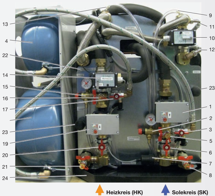
Fig. 3 Anschlüsse und Komponenten im Wärmepumpenmodul
