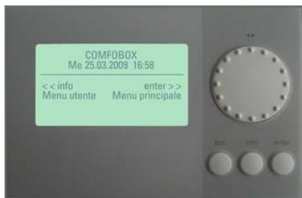
Fig. 6 Dispositivo di comando ComfoBox, versione Elesta (riscaldamento, condizionamento, acqua calda)
